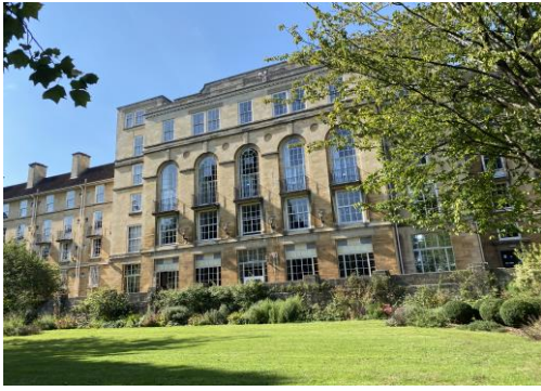
庭から見た寮の外観
